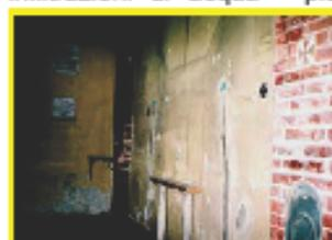
causate dalla mancanza di adeguati scarichi pluviali che imbibivano il muro, e da formazioni di sali sull'intonaco in cemento altamente assorbente, realizzato purtroppo nel
